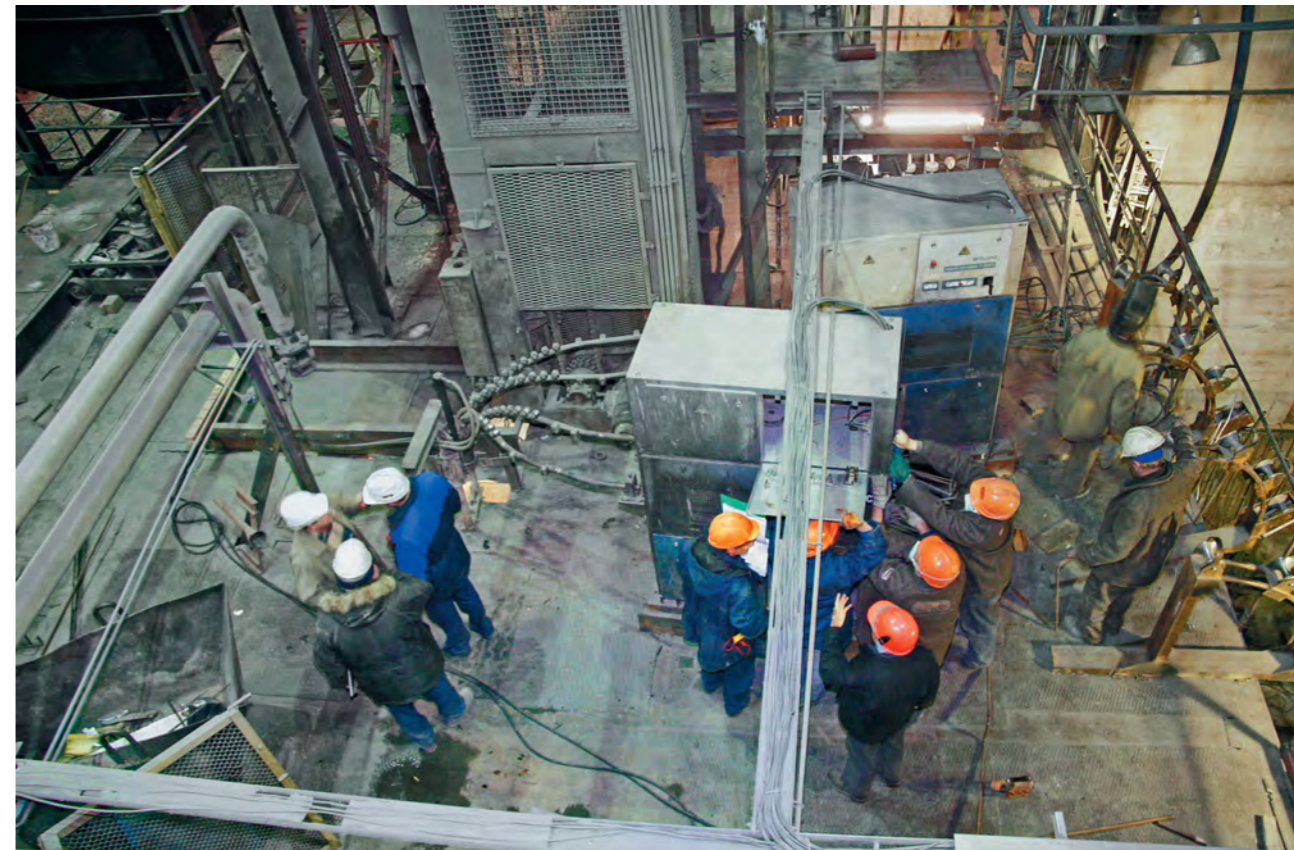
Монтаж нового электрооборудования установки циркуляционного вакуумирования стали №3. 2008 год
