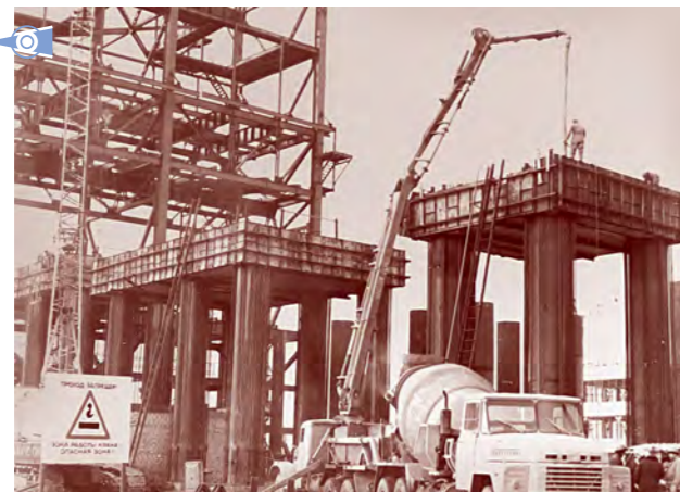
Известковый цех. Отделение вращающихся печей. Ведётся бетонирование верхней плиты опор с применением бетононасоса БН 80-20. 1983 год
