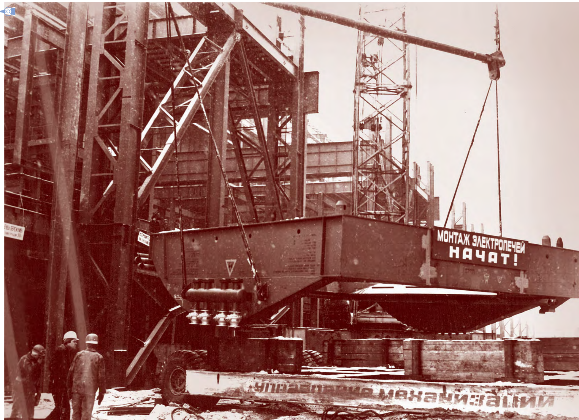
Монтаж электропечей в ЭСПЦ №2. 1983 год
