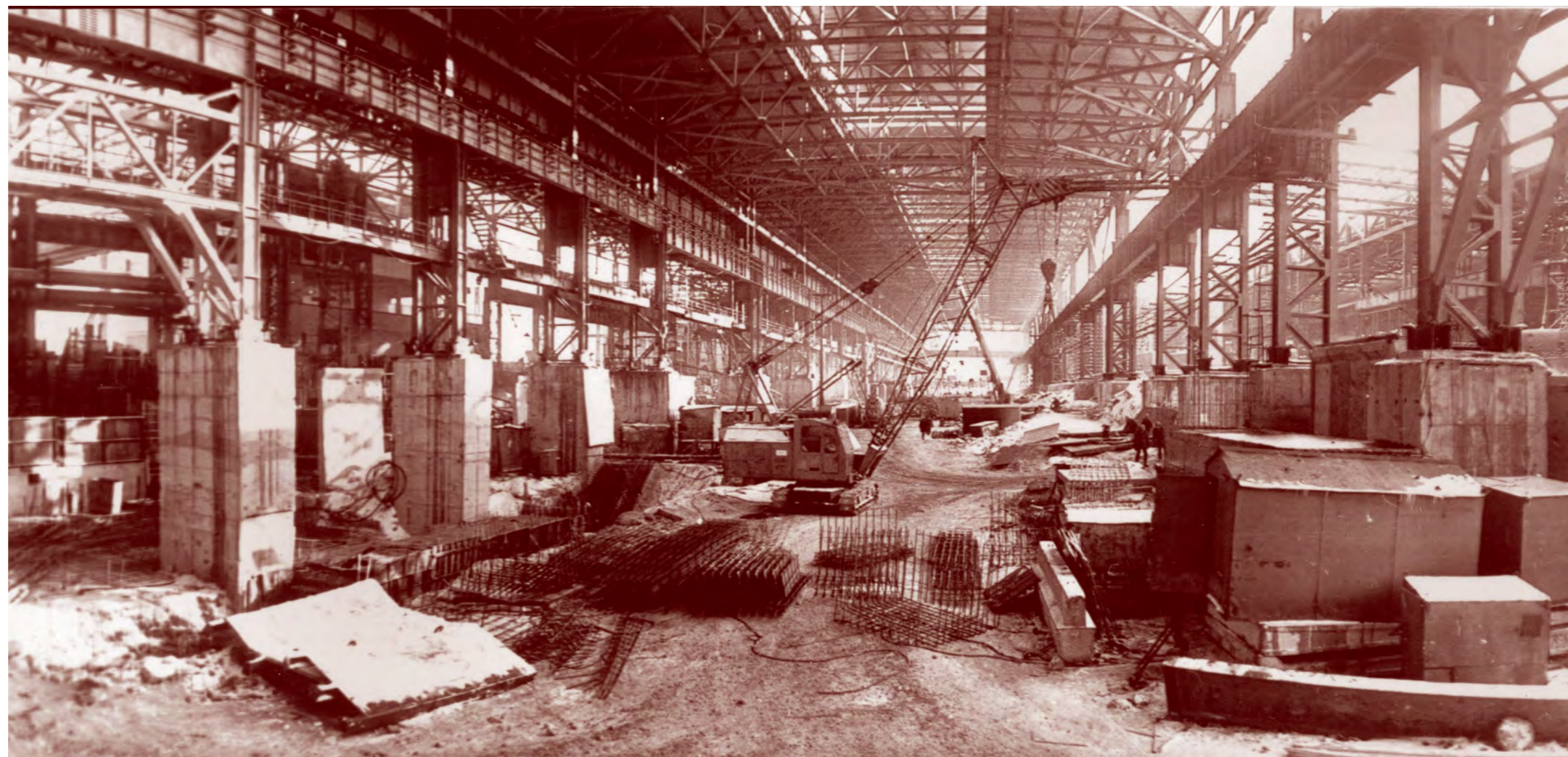
Строительство участка машин непрерывной разливки стали. Декабрь 1985 года
