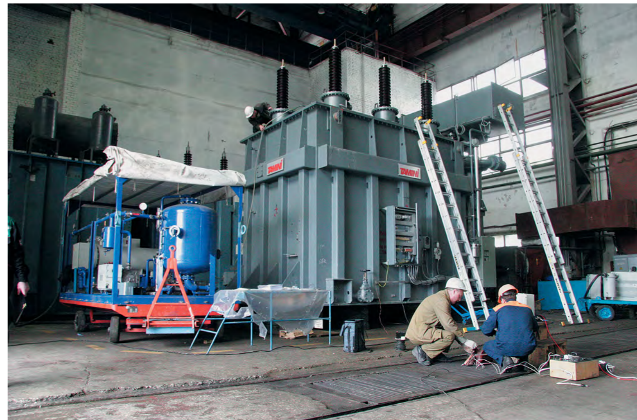
Сборка трансформатора ТАМІНІ в ЭЭРЦ. 2007 год
