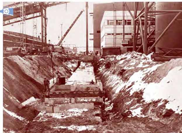
Строительство кабельных тоннелей ЭСПЦ № 2. 1984 год
