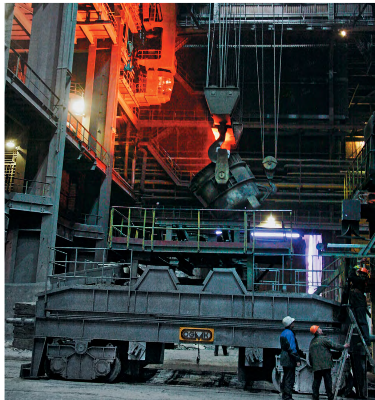
Подготовка к испытанию нового сталевоза, изготовленного на ОЭМК. Декабрь 2007 года
