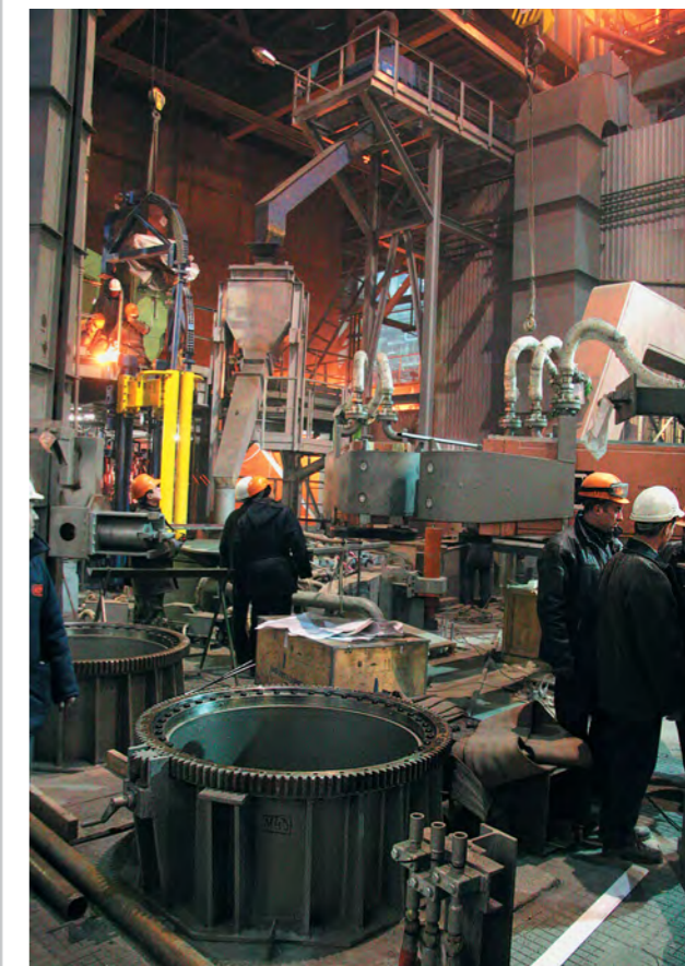
Монтаж оборудования АКОС №3. 2008 год
