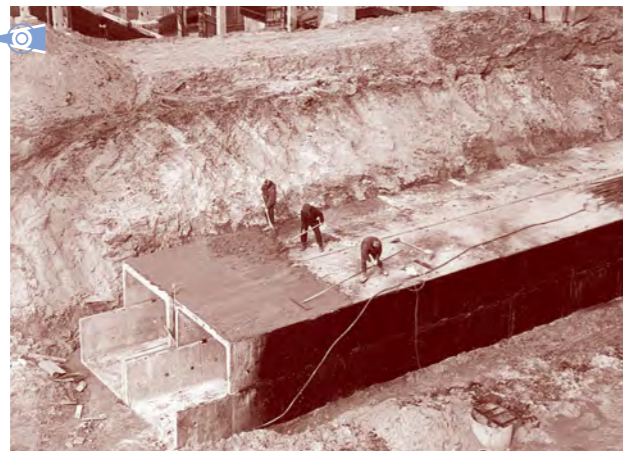
Воздушные тоннели центральной вентиляционной станции ЭСПЦ №2. 1983 год
