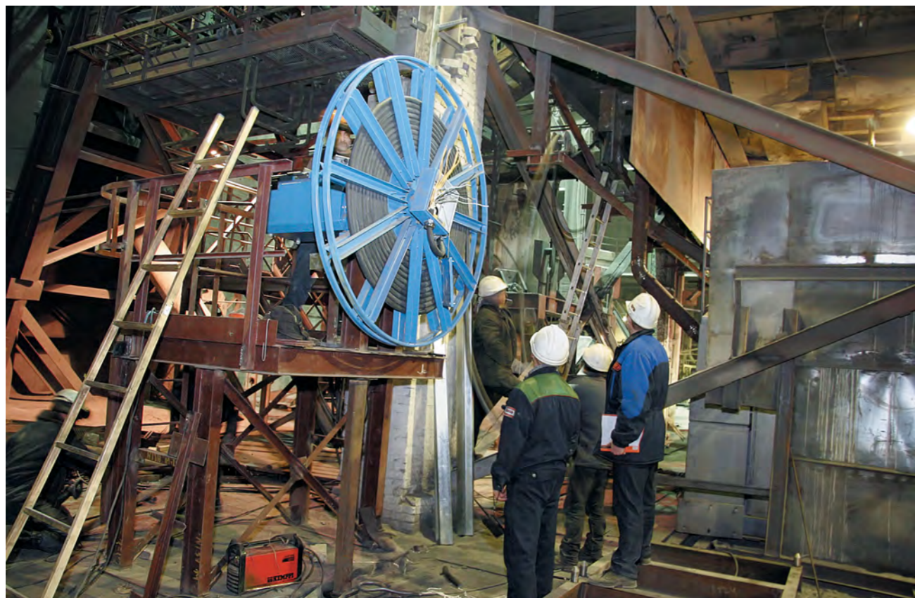
Монтаж теплозащиты и кабельного барабана установки циркуляционного вакуумирования стали №3. 2008 год
