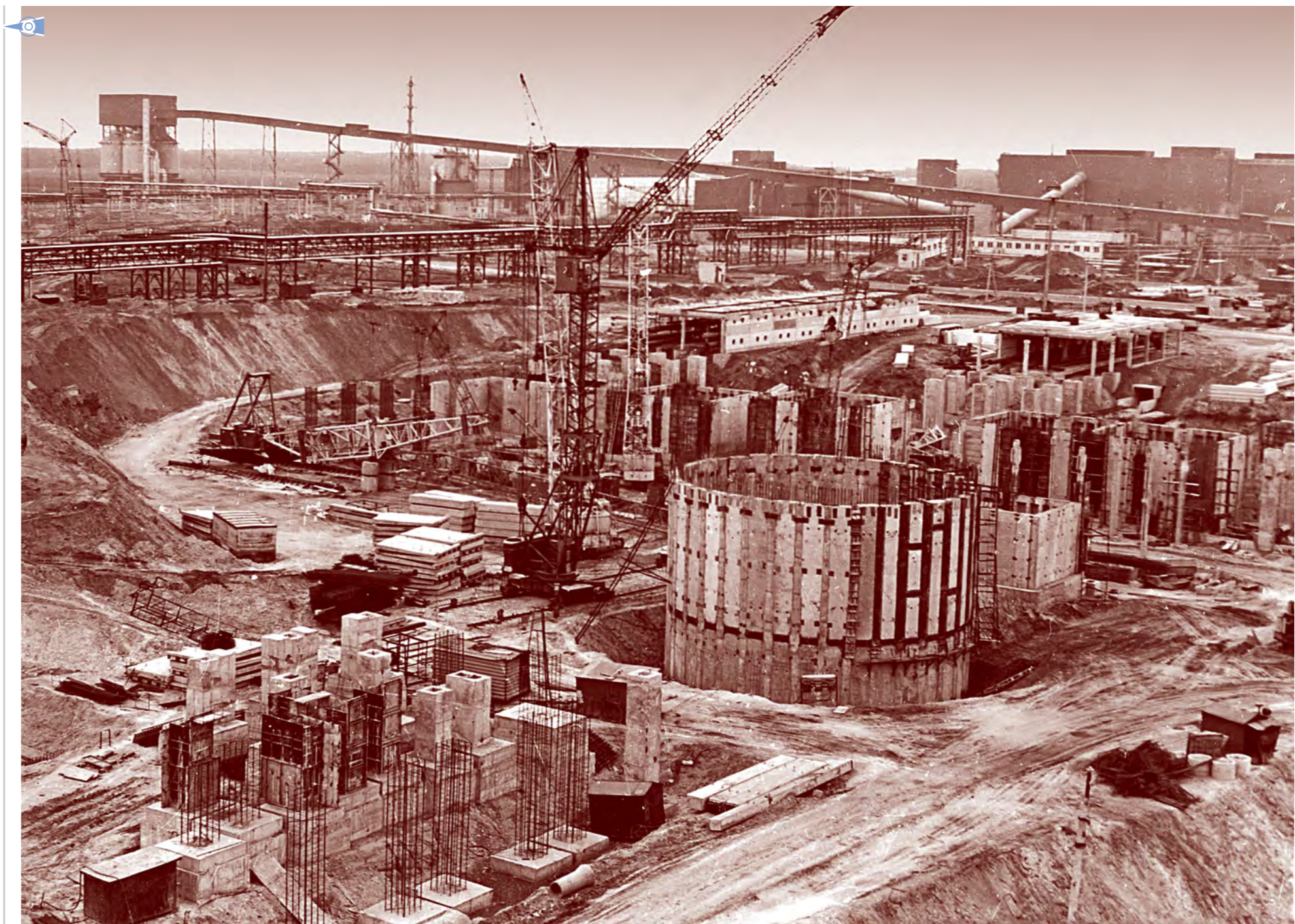
Фундаменты участка водоподготовки. 1983 год
