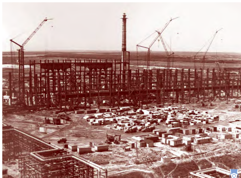
Главный корпус ЭСПЦ №2. 1982 год
