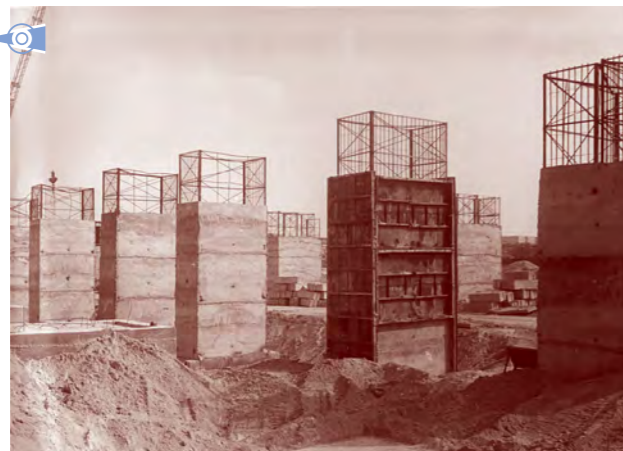
Применение несъемной опалубки на фундаментах ЭСПЦ №2. 1981 год
