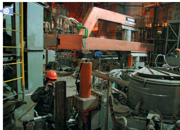
АКОС №3. Монтаж оборудования. ЭСШ. 2008 год
