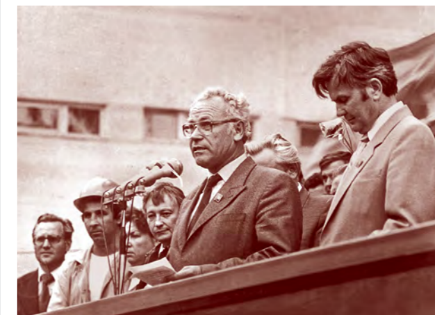
Выступает начальник ПСМО «Электрометаллургстрой» В.Е. Труфанов. 14 августа 1984 года
